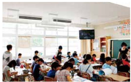
町内の全小中学校に、空調設備を設置しました。
