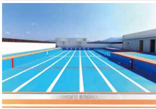
児童数増加に対応するため、中原小学校の校舎を増築し、増築した校舎の屋上にプールを整備しました。
