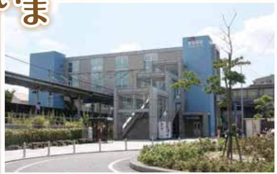
平成13年8月 JR篠栗線(福北ゆたか線)の電化に伴い、長者原駅が改築され現在の駅舎に。
