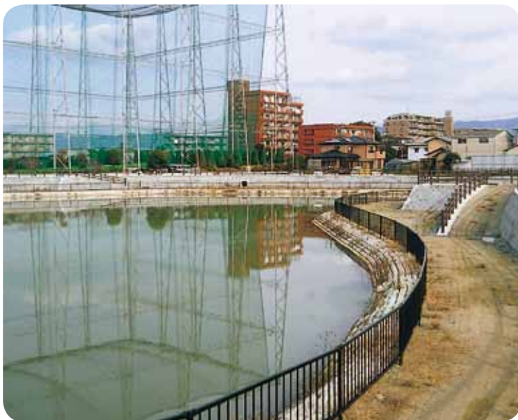
工事中の大池公園
