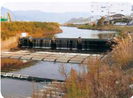
40年経過した有崎堰の取替
