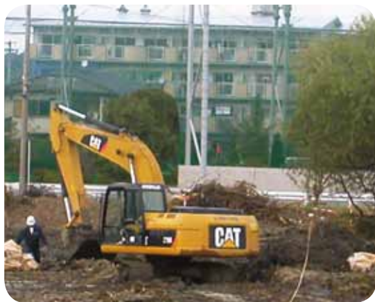
公共事業の工事現場
