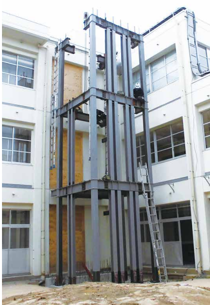
粕屋中学校建設中のエレベーター
