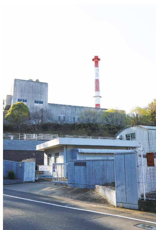
浄水場(手前)と旧焼却場
