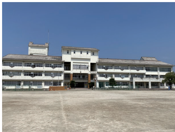
教室の増設が待たれる粕屋中央小学校
