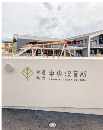
建て替えられた町立中央保育所
